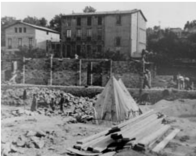
Obres de construcció de la piscina municipal, que es va inaugurar l'agost del 1932 (col·lecció particular d'Amadeu Bargay).
